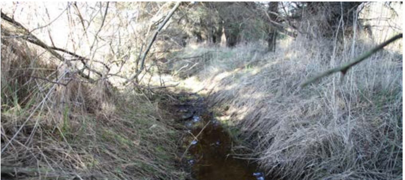
Foto 8 Afvandingskanal i lokalplanområdet.
