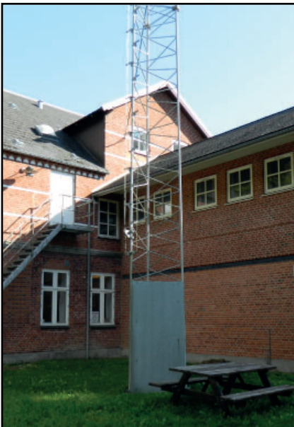
Antenneanlæg vest for bygningen.
