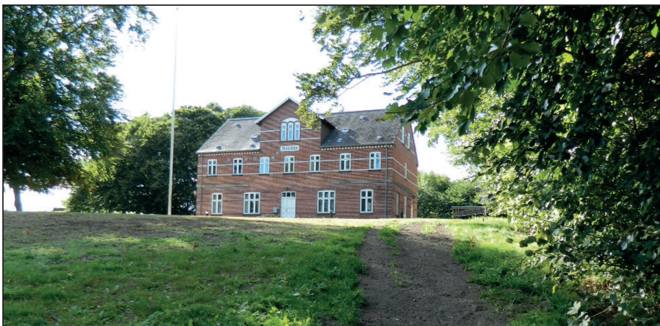
Den bevaringsværdige bygning Rolykke, der findes på lokalplanområdet. Bygningen er registreret med bevaringsværdi 2.
