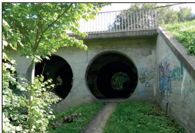
Tunnel under Ålborgvej indgår i nabolagets stiforbindelse.
