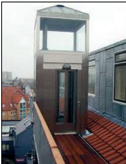
Eksempel på et delvist udvendigt elevatortårn. – billede fra Mini Elevator – Ahr.dk.
