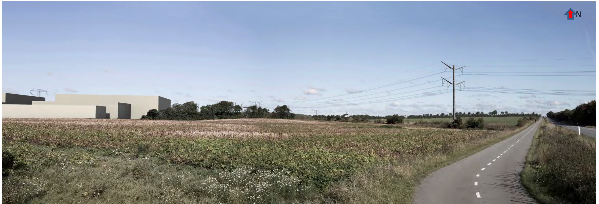
Alternativ 2 fra Gestenvej og mod nord. (Fotostandpunkt 3)
