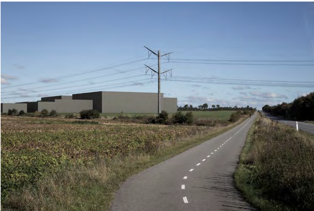
Foto 7.7 Fra samme punkt ses det nye anlæg illustreret i en mørk grå farvesætning, i et design hvor en stor del af de tekniske installationer er indkapslet i lukkede bygninger. De to volumener tv. i billedet vil blive etableret som udendørs anlæg.
