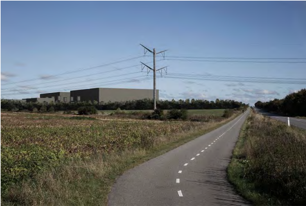
Foto 7.13 Her er stationen illustreret i et design hvor en større del af de tekniske installationer står frit. (De to volumener tv. i billedet vil blive etableret som friluftsanlæg).
