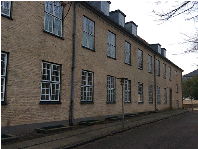
Eksisterende bevaringsværdig bebyggelse i 2 etager inden for delområdet
