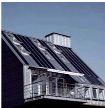
Solceller indarbejdet i tag.
