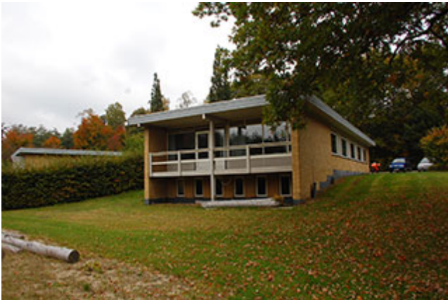
Elevboliger som forventes nedrevet.
