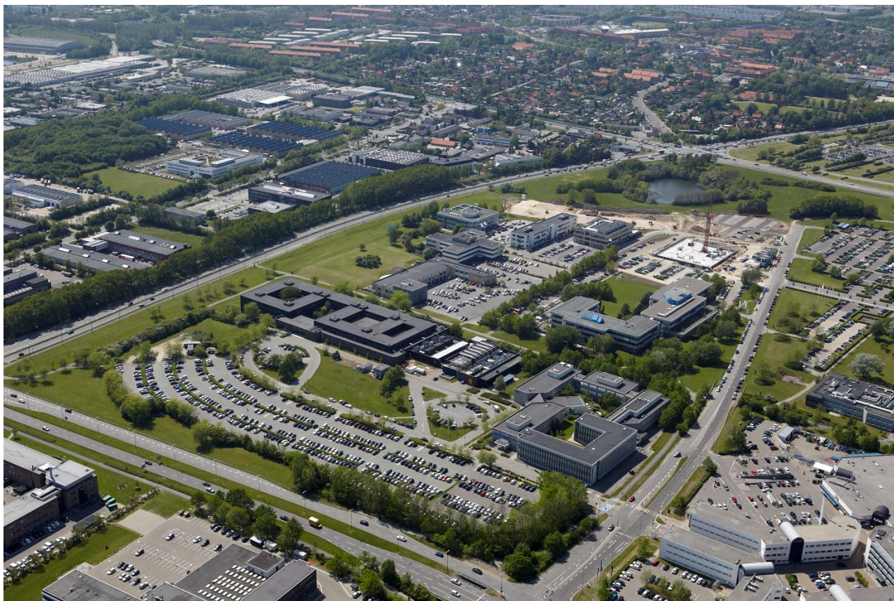
Borupvang set fra øst i retning mod Ring 4
